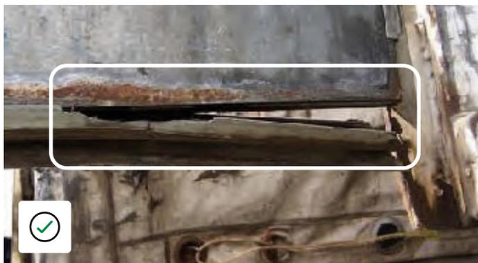
Ancienne porte présentant une corrosion de la surface interne, dommages aux joints en raison d'une utilisation continue, pas de déformation du panneau de la porte.
