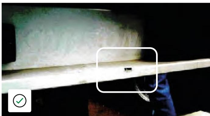
Domage dû à un impact qui n'a pas déformé le matériel et qui peut être réparé à faible coût par un nettoyage et une couche de peinture.
