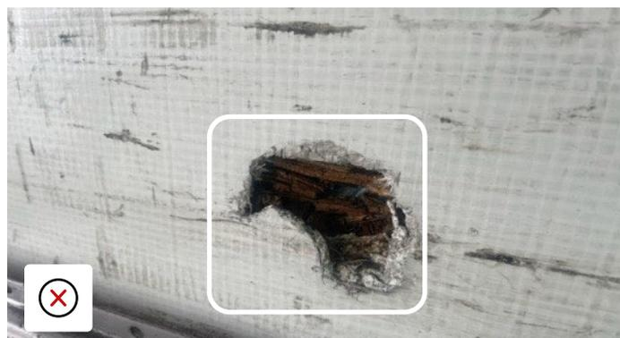
Panneau en fibre de verre perforé et structure bois apparente.
