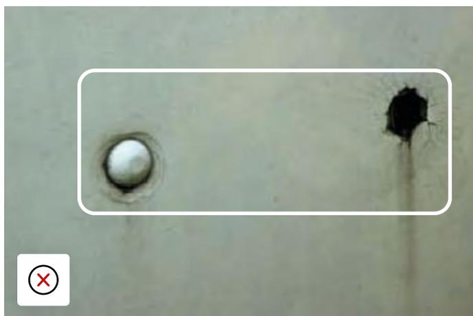
Boulons fixés au travers des panneaux latéraux en stratifié de fibres de verre.
