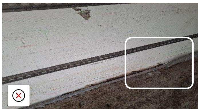
Lisse de protection endommagée et arrachée du panneau.
